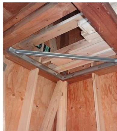
火打ち金物補強
