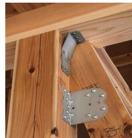
耐震金物補強
